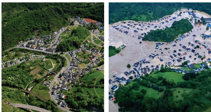
Área urbana de Schuld, Oeste da Alemanha, antes (à esquerda) e depois (à direita) da inundação de julho/2021. Disponível em https://www.dw.com/ .
